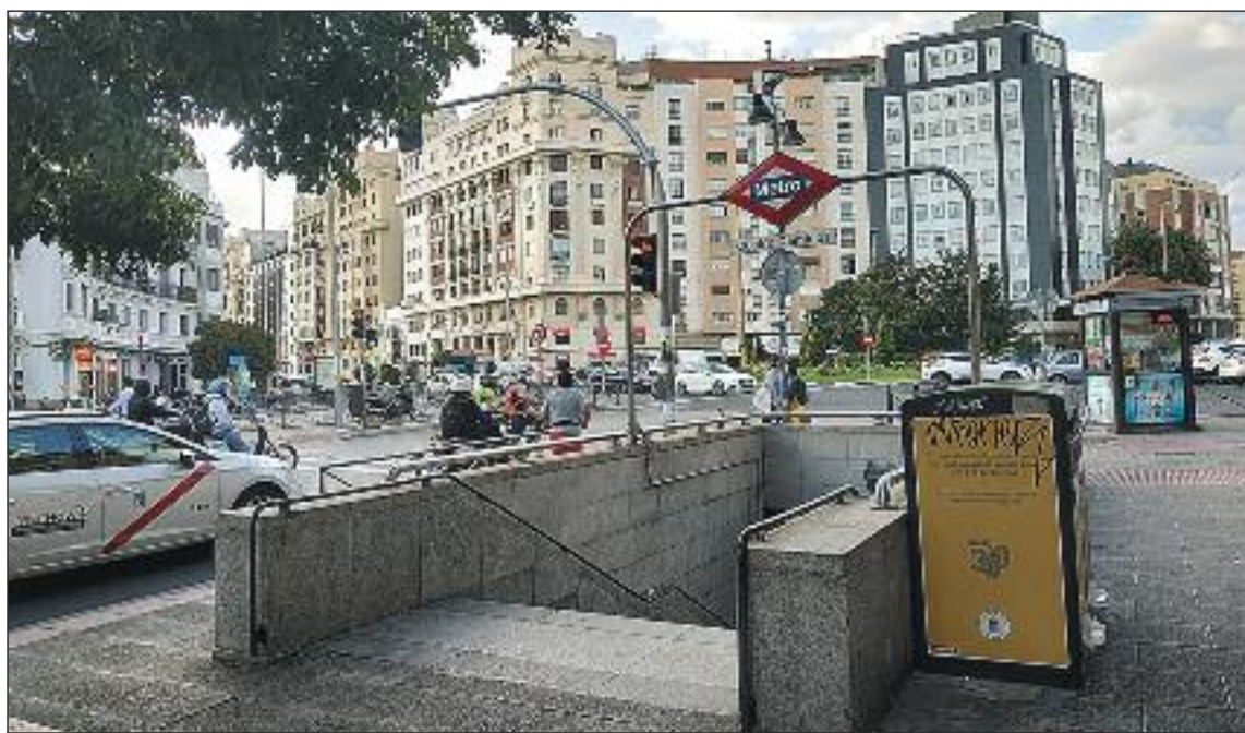
Los trabajos favorecerán la accesibilidad y cuentan con un presupuesto de más de cinco millones de euros.
