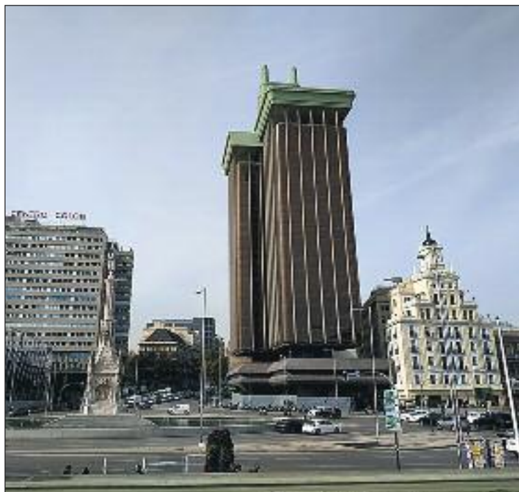
El aumento de la protección de las Torres Colón al nivel 2 supondría blindar su estructura.
